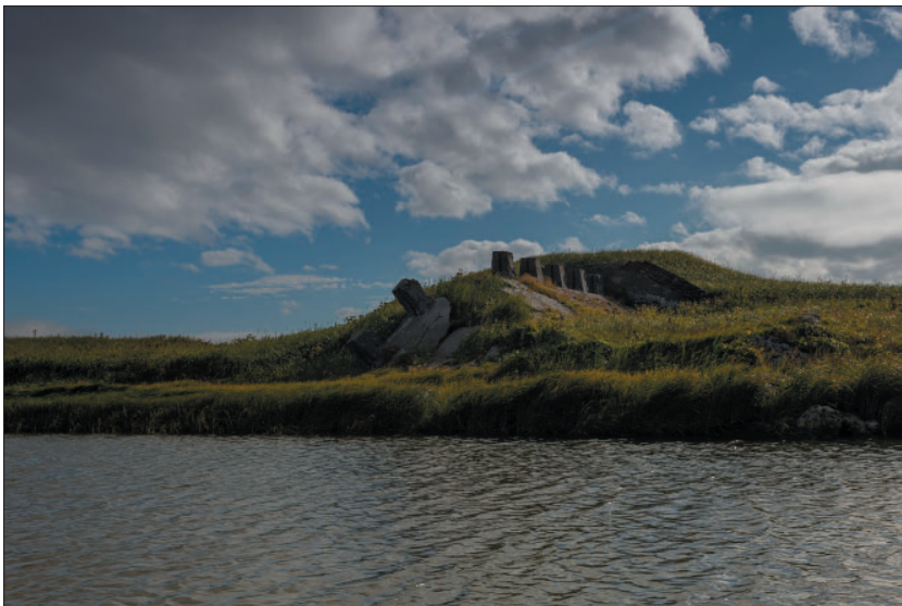
Рис. 42. Фрагмент плотины на протоке Беттобу
