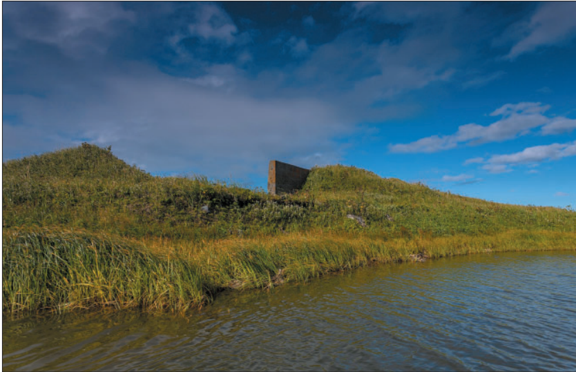
Рис. 43. Фрагмент плотины на протоке Беттобу
